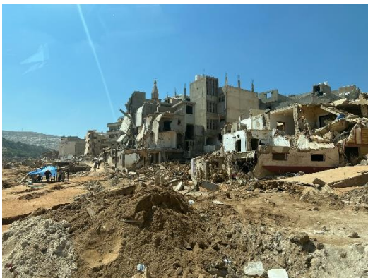
強力な暴風雨「ダニエル」によって崩壊した建物 ©UNHCR/Ahmed Al Houdiri
